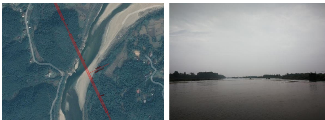
图 2.1-12 本项目潜水特大桥位置及现场照片
