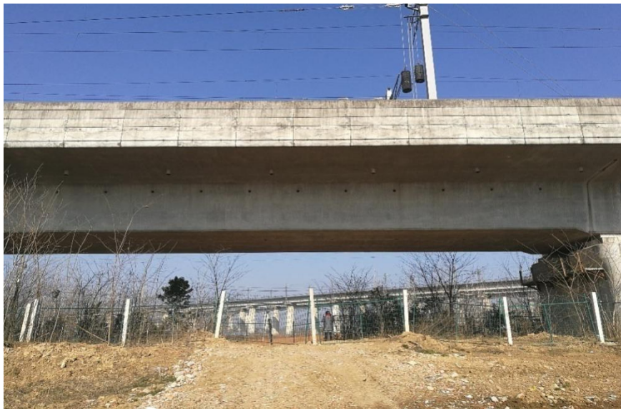
沪蓉铁路现状照片
