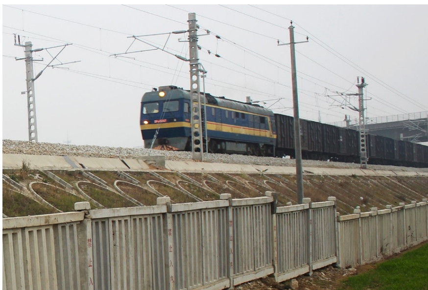
宁西铁路现状照片
