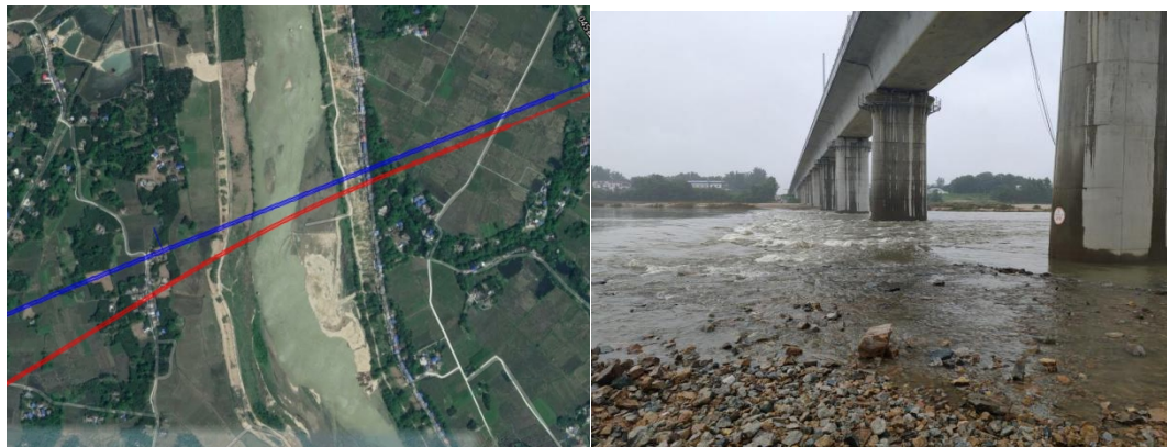
图 2.1-14 潜山特大桥（跨潜水）位置及现场照片
