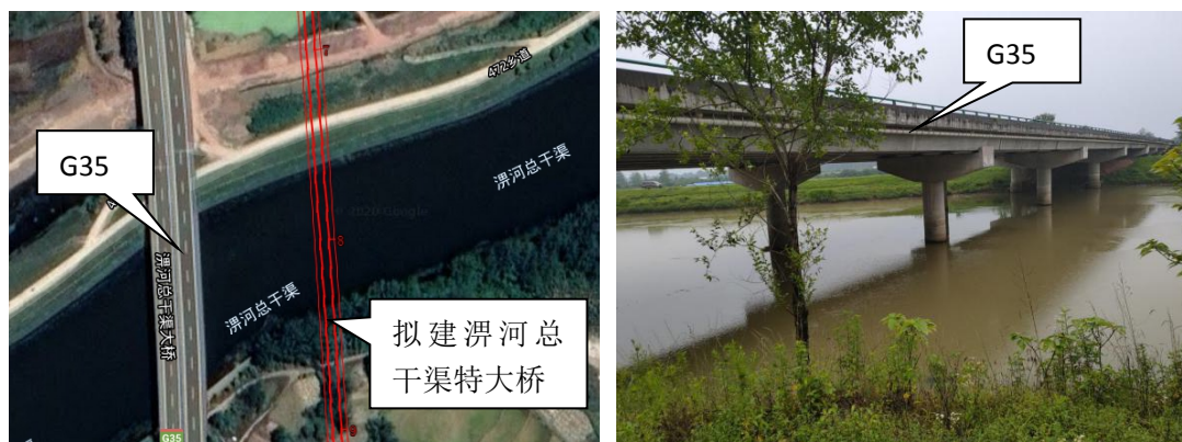
图 2.1-10 本项目淠河总干渠特大桥位置及现场照片
